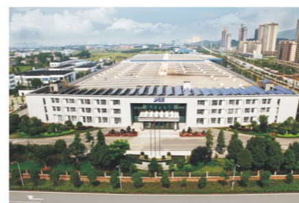
黄石研发中心 Huang shi R&D Center 黄石工厂 Huang shi Plant
